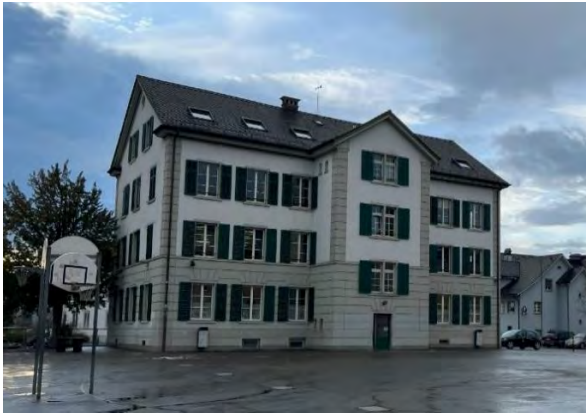
Fassade zu Pausenplatz
