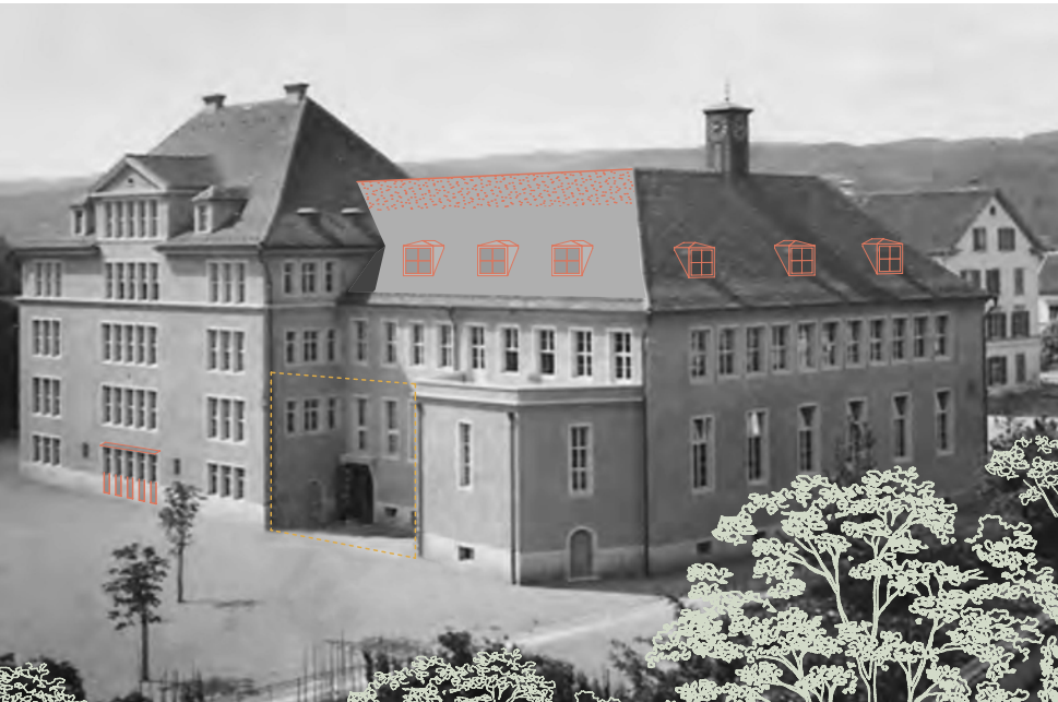
Rückbau der nachträglichen Erweiterung
