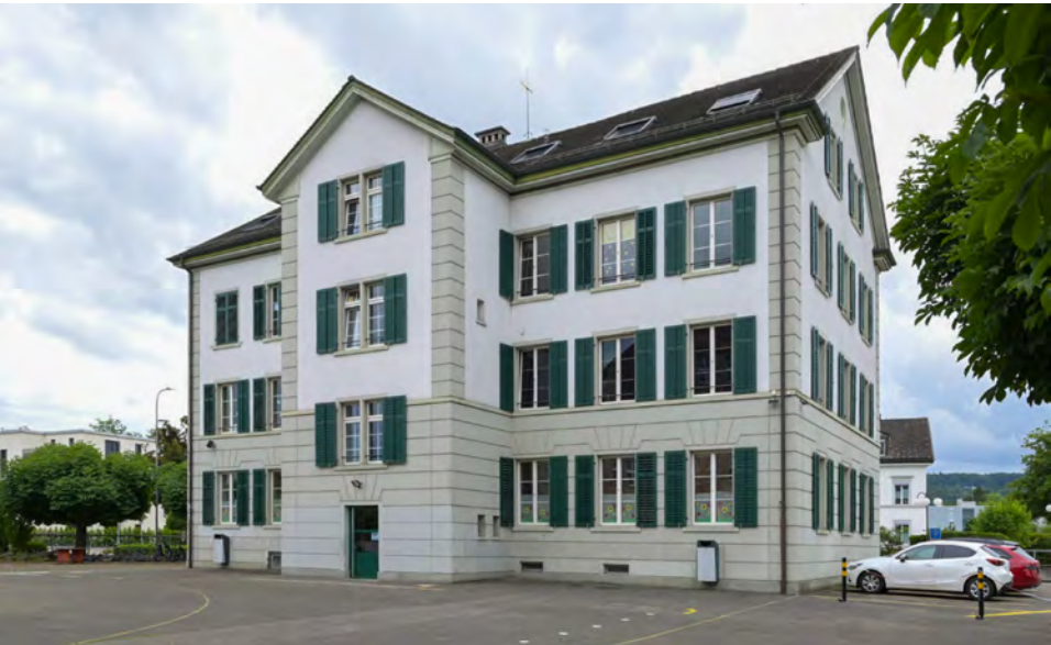
Haus A - erhaltenes historisches Erscheinungsbild
